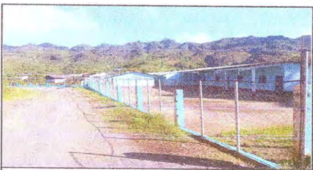
Foto 5: Parte del muro perimetral.
